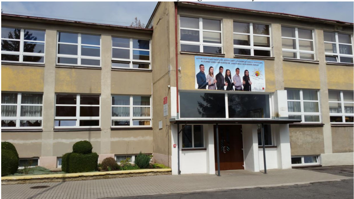
Fot. nr 2. Elewacja południowa– widoczna wymieniona stolarka okienna oraz wejście główne do budynku.
