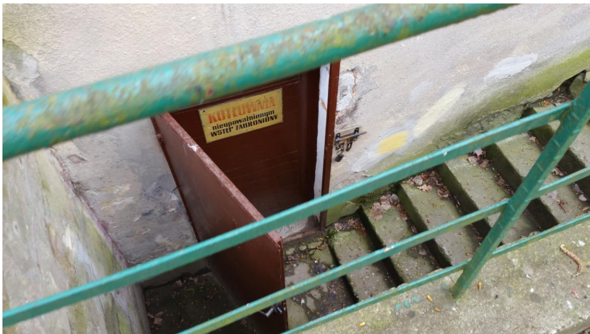
Fot. nr 7. Elewacja północna. Fragment wejścia do piwnicy – widoczne drzwi gospodarcze przeznaczone do wymiany.
