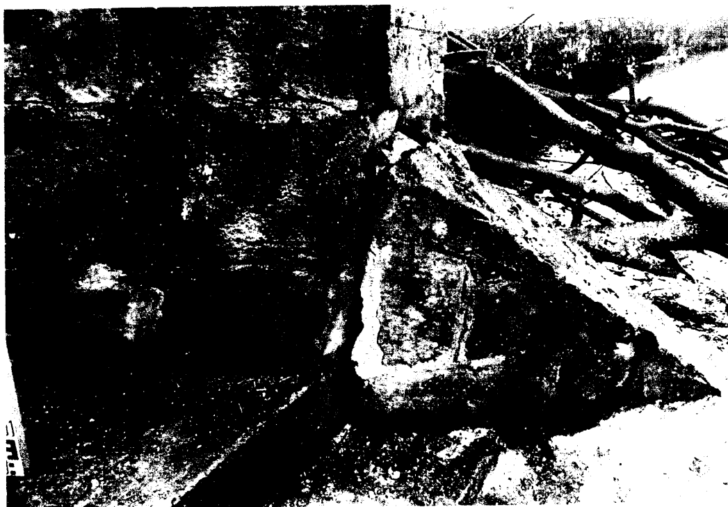
Fot. Nr 13 Widoczne uszkodzenie skrzydełka lewobrzeżnego od strony górnej wody widoczne spękanie i ubytki spoinowania murka bariery
