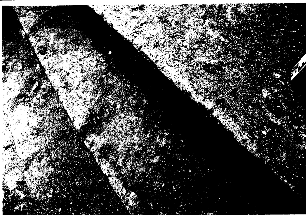
Fot. Nr 12 Widok szczeliny przy stopniu na dojściu lewobrzeżnym, spływająca woda opadowa z kładki powoduje lokalne rozmywanie podłoża i jego osiadanie
