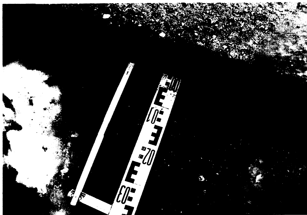
Fot. Nr 18 Widoczne przemieszczenie konstrukcji stopnia na dojściu prawobrzeżnym powstała szczelina o wielkości 2÷8 cm, w wyniku osiadania podłoża, woda opadowa powoduje lokalne rozmywanie podłoża i jego osiadanie
