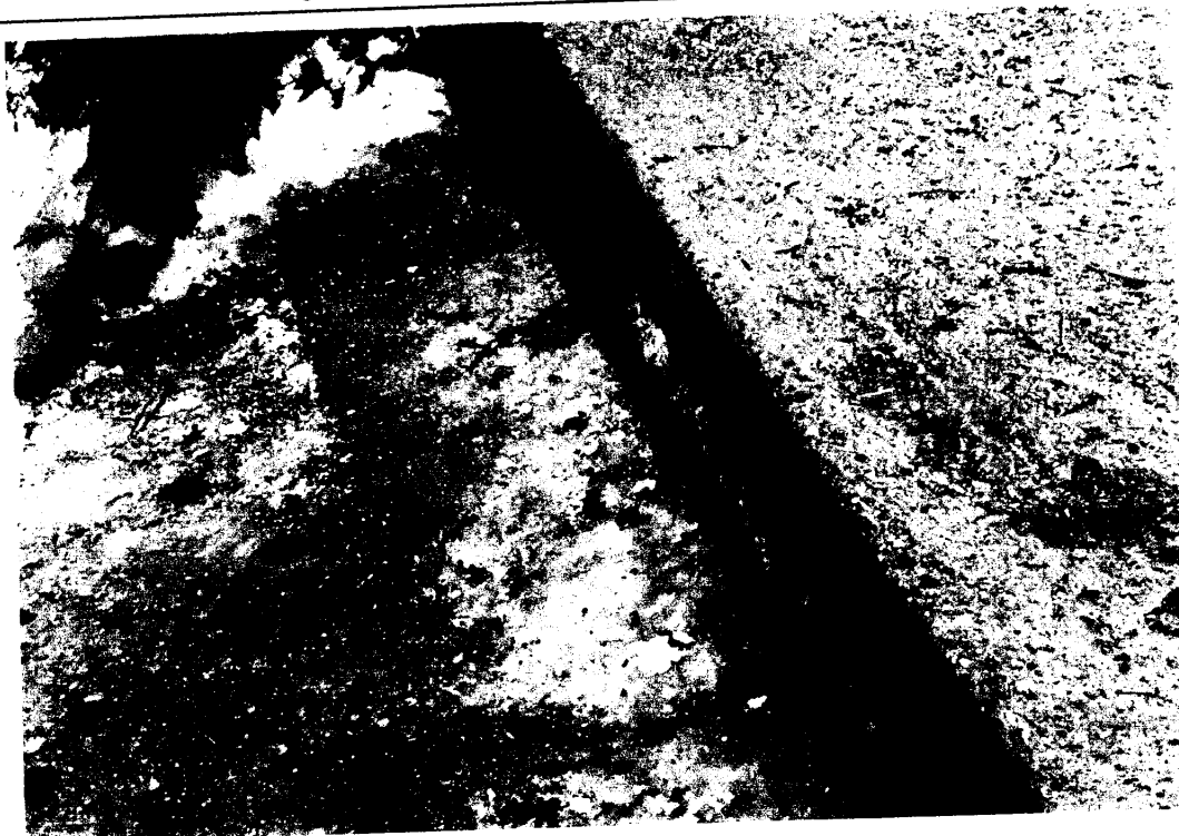
Fot. Nr 2 Widoczne przemieszczenie konstrukcji stopnia na dojściu prawobrzeżnym powstała szczelina o wielkości 2÷8 cm
