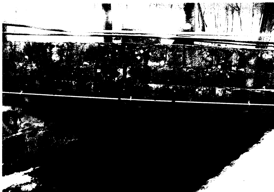
Fot. Nr 16 Widok kładki od strony dolnej wody, widoczne zanieczyszczenie koryta potoku -rumosz i namulisko przy przyczółku prawobrzeżnym, porost roślinnością konstrukcji kamiennej bariery
