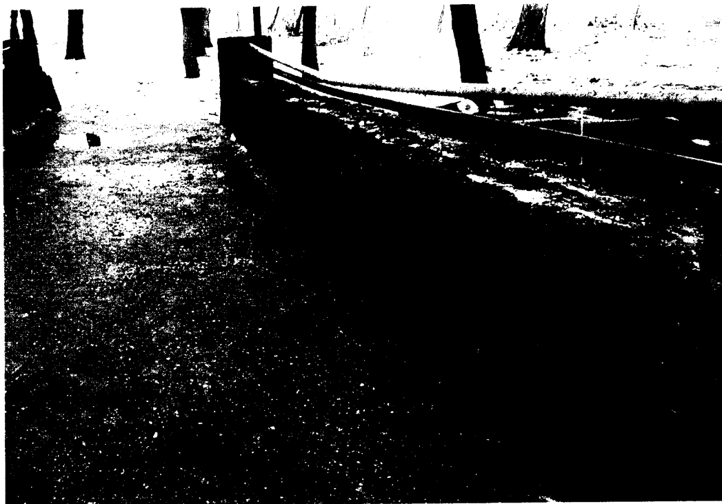
Fot. Nr 9 Widok kamiennego murka bariery i pogniętych poręczy - od strony górnej wody, widoczne fragmenty drzewa które powaliło się przed kładką do potoku
