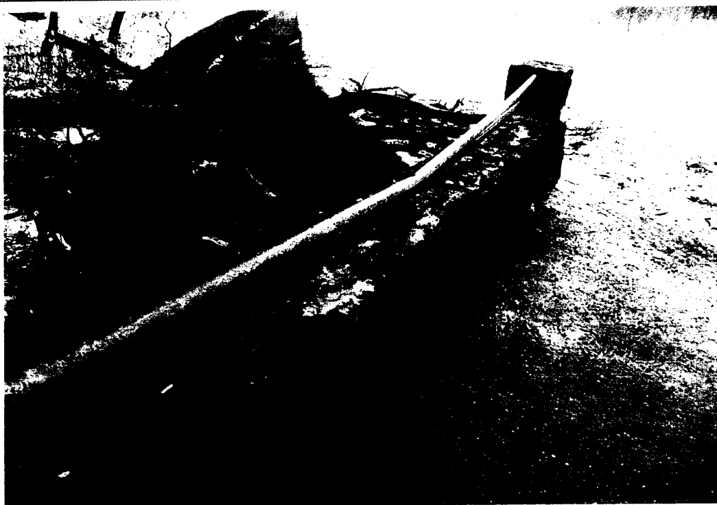
Fot. Nr 10 Widok od strony górnej wody przy przyczółku lewobrzeżnym, widoczne pognięte rury poręczy mostowych, widoczny porost roślinności na konstrukcji kładki powodujący powstawanie uszkodzeń korozyjnych
