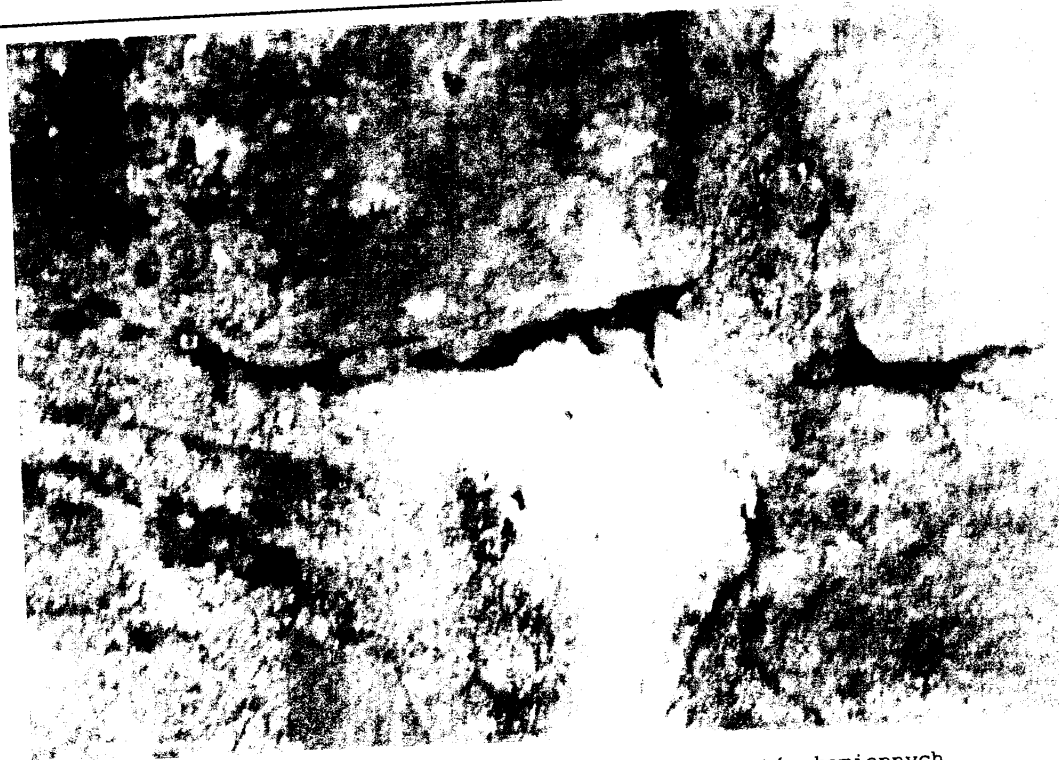
Fot. Nr 10 Widok ubytków spoinowania elementów kamiennych przyczółka prawobrzeżnego
