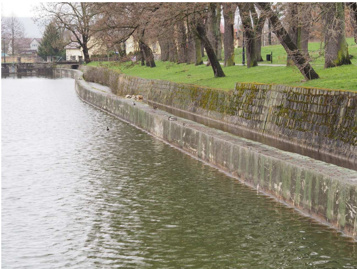
Rys. 1.2. Kamienny mur oporowy pomiędzy Stawem Zdrojowym a korytem potoku Trzemeszna
