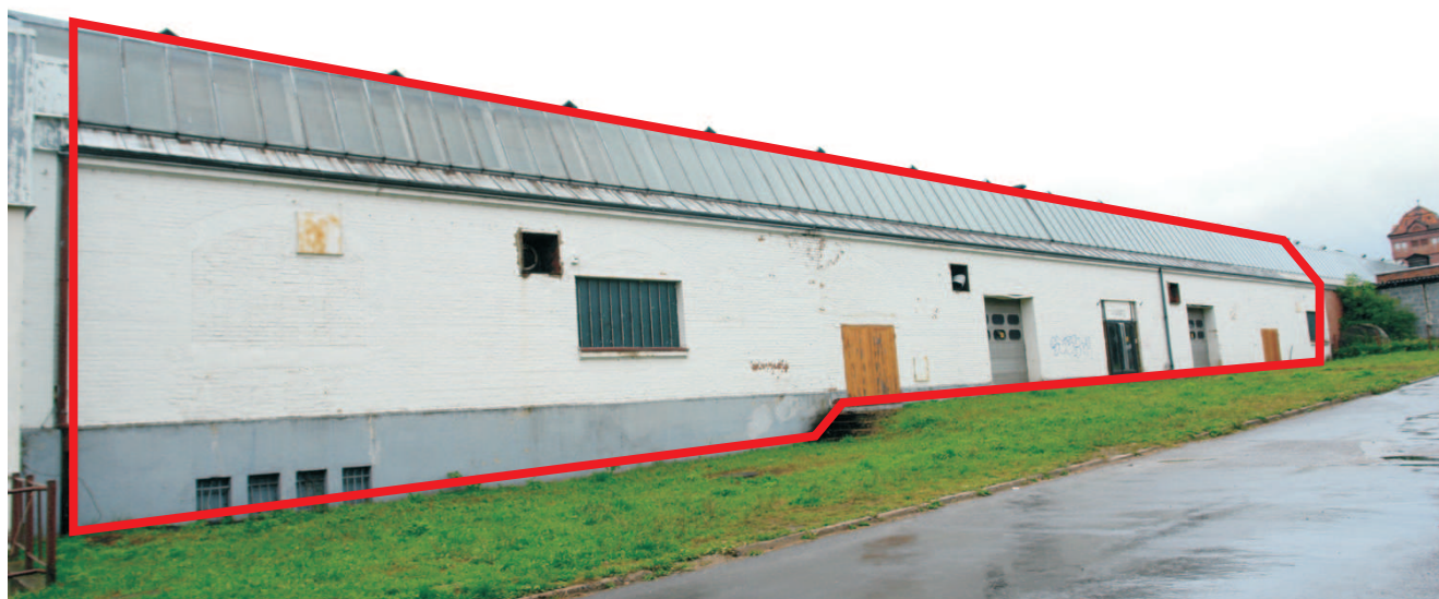
elewacja frontowa hali od ul. Fabrycznej
