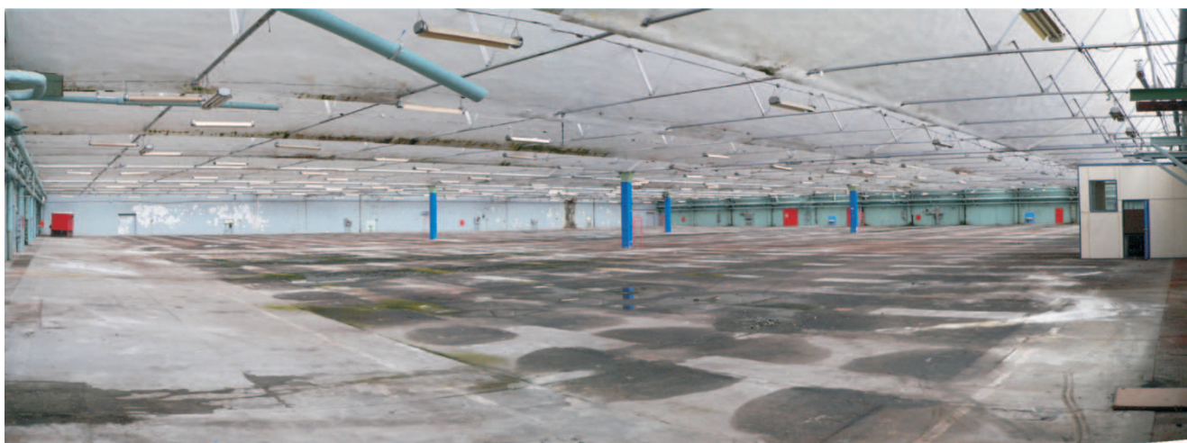
hala przemysłowa wewnątrz zdjęcie panoramiczne
