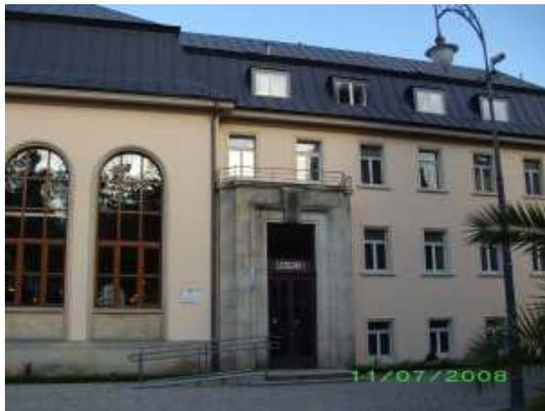
Rys.4. Budynek Łazienki I
